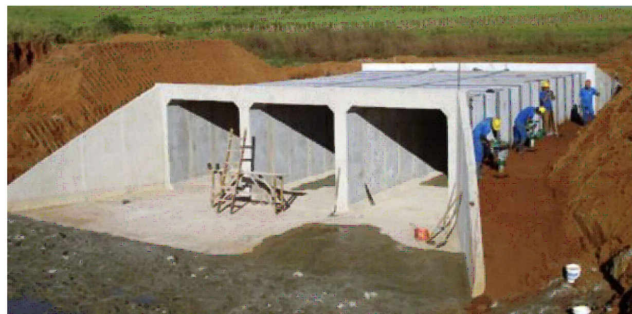
VISTA FRONTAL DA OBRA
