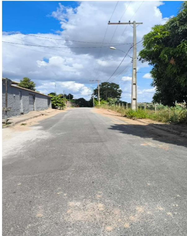
FOTO 33: Rua Antônio do Amparo Rodrigues (Trecho J-K)
