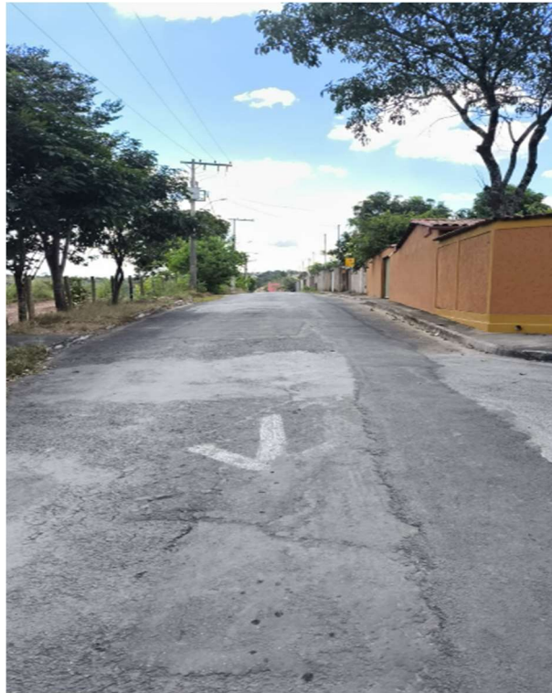
FOTO 31: Rua Antônio do Amparo Rodrigues (Trecho J-K)
