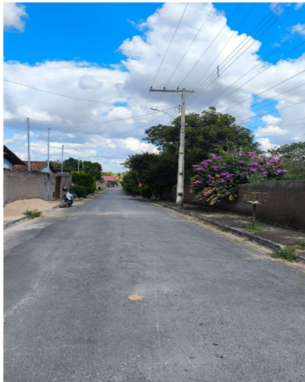
FOTO 38: Rua Antônio do Amparo Rodrigues (Trecho J-K)
