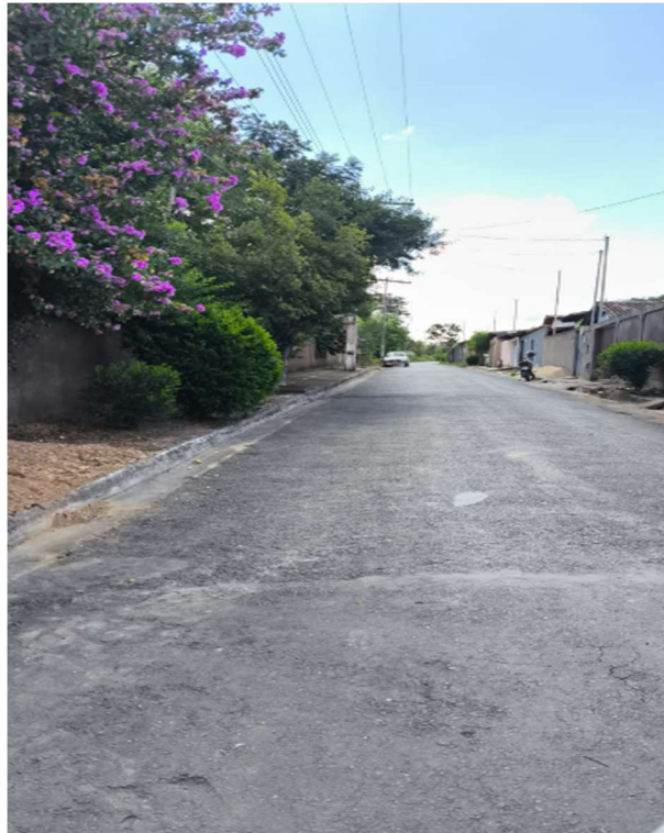
FOTO 37: Rua Antônio do Amparo Rodrigues (Trecho J-K)
