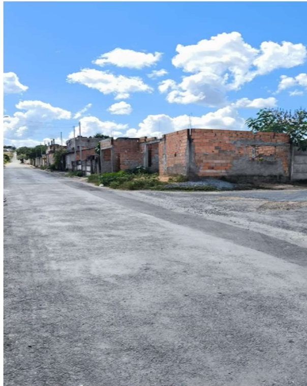
FOTO 35: Rua Antônio do Amparo Rodrigues (Trecho J-K)
