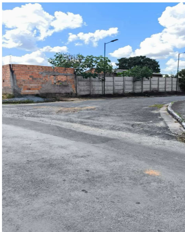
FOTO 36: Rua Antônio do Amparo Rodrigues (Trecho J-K)
