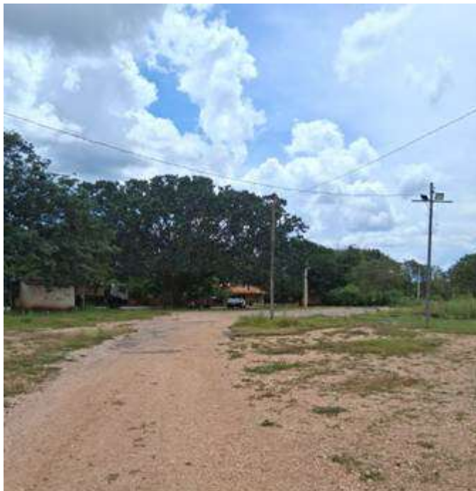
FOTO 05: RUA SÃO JOÃO TRECHO 2
