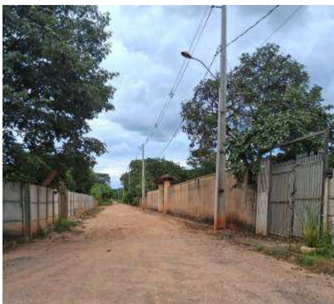
FOTO 01: RUA SÃO JOÃO TRECHO 1
