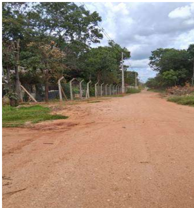
FOTO 02: RUA SÃO JOÃO TRECHO 2
