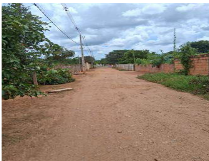
FOTO 02: RUA SÃO JOÃO TRECHO 1
