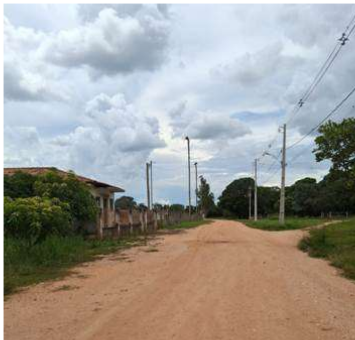
FOTO 04: RUA SÃO JOÃO TRECHO 2
