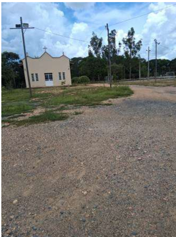
FOTO 06: RUA SÃO JOÃO TRECHO 2
