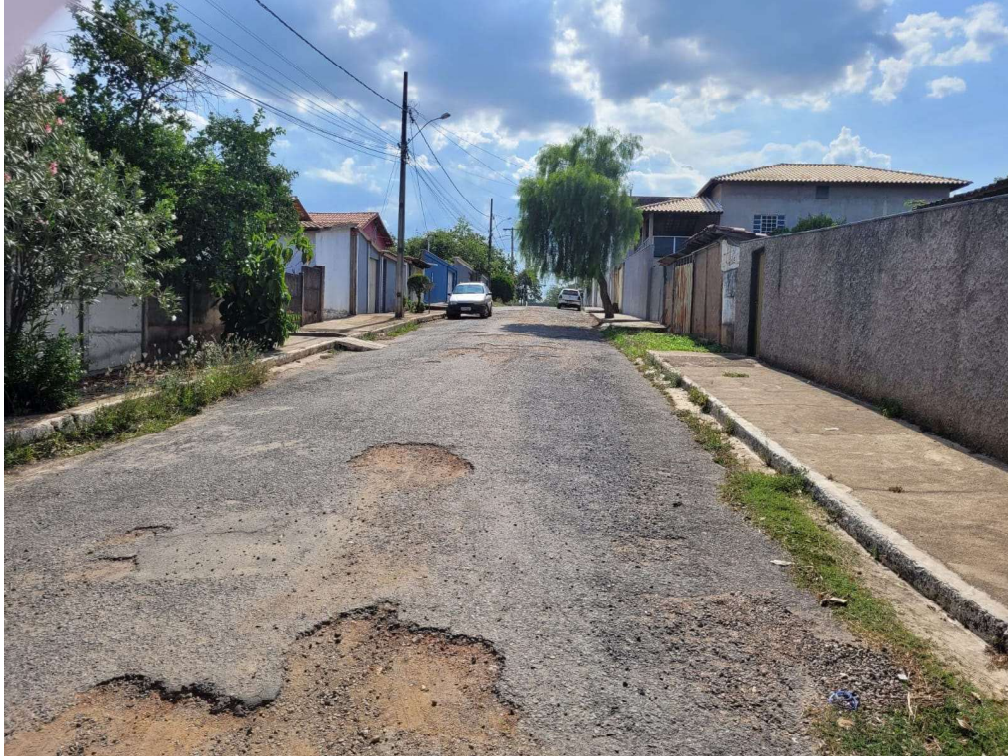
Foto 1: Rua São Geraldo
